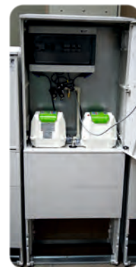
Energooszczędne dmuchawy JDK-S z zabezpieczeniem przebiecia membran
