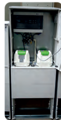
Energooszczędne dmuchawy JDK-S z zabezpieczeniem przebiecia membran
