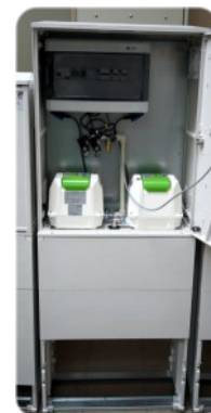
Energooszczędne dmuchawy JDK-S z zabezpieczeniem przebiecia membran
